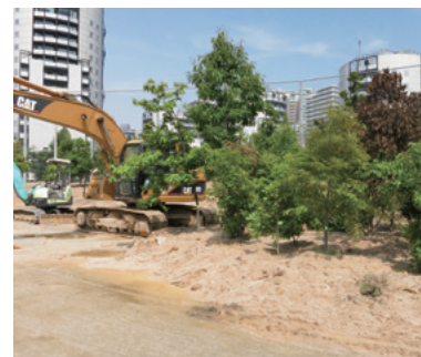
西南の森工事
