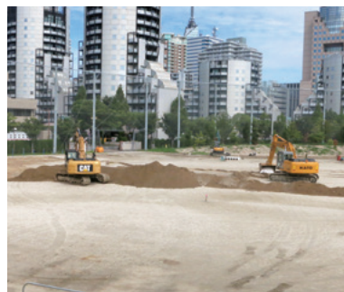
グラウンド工事
